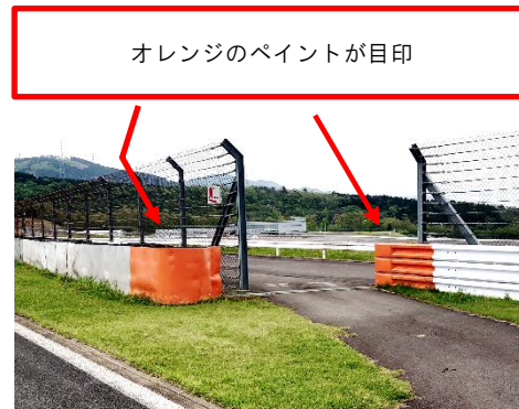
<図3>サービスロード開口部
