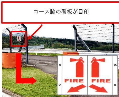
<図2>消火器の設置場所
