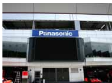
サーキットビジョン(3面あり)
