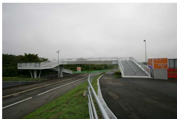
<歩車分離のための歩道橋>
